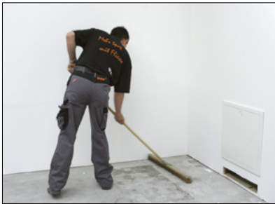
1 Reinigen des ausreichend tragfähigen und ebenflächigen Untergrundes.
