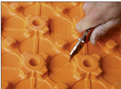
3b Verarbeiten der Estrichnoppenplatte – Schneiden zwischen den Noppen: mit scharfem Messer/ Cutter anschneiden ... und brechen.
