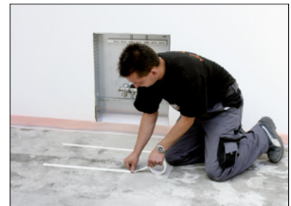
5 Verteilerbereich – beiliegendes Doppelklebeband auf dem Boden anbringen.
