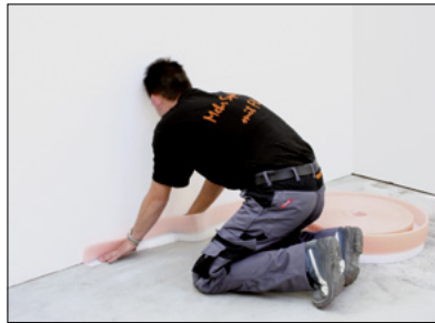
2 Einbau des Randstreifens BRS 808 KSF mit Klebestützfuß.
