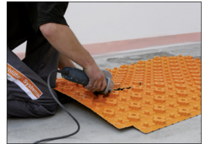
3a Verarbeiten der Estrichnoppenplatte – Schneiden im Noppenbereich: Winkelschleifer benutzen.
