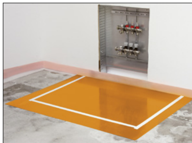
7 Verteilerbereich – beigefügte Doppelklebebänder aufbringen.
