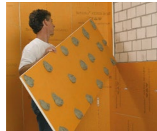
Na ścianach stanu surowego i podłogach mieszanych
