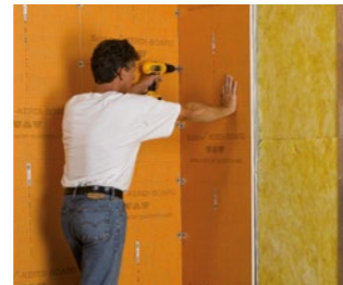
Na konstrukcji szkieletowej
