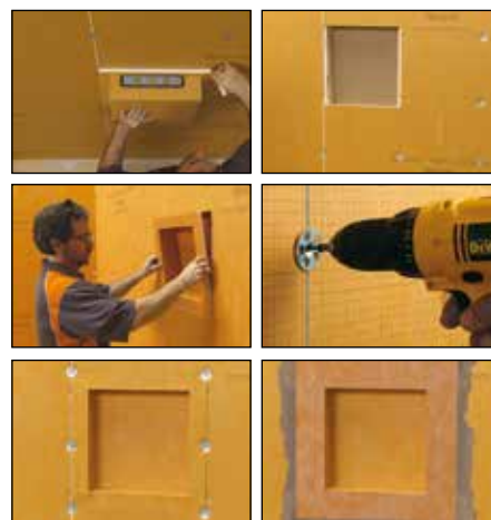
Zabudowa w KERDI-BOARD
