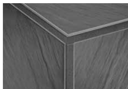
Wykonanie narożnika z profilami i kształtką narożną
