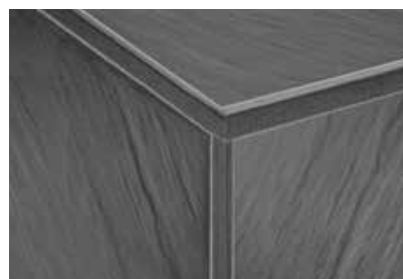
Wykonanie narożnika z docinaniem profilu
