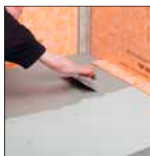
ad 6. Nanieść zaprawę cienkowarstwową
