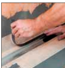
Dot 1. W przypadku zabudowy przyściennej: pasek przykrywający przykleić do ściany
