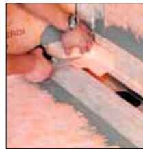
Dot 2. Manszetę KERDI przykleić/ narożnik wewnętrzny KERECK przyciąć
