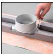
ad 3. Adapter ponownie przykręcić
