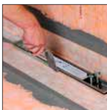
Dot 3. Pod ramkę nanieść zaprawę/ ulożyć płytki powierzchniowo
