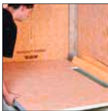
ad 3. Płytę ze spadkiem włożyć pod krawędź rynny
