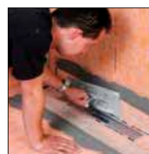
ad 4. Manszetę KERDI przykleić klejem KERDI-COLL-L
