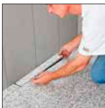
Dot 6. Posadzkę nakleić – nie fugować obszaru podstawy pod posadzkę
