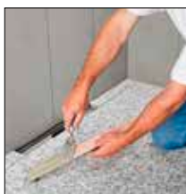
Dot 5. Podstawę posadzki pokryć zaprawą cienkowarstwową
