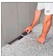
Dot 4. Posadzkę wymierzyć do podstawy posadzki...
