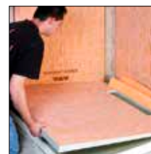
ad 3. Płytę ze spadkiem wsunąć pod krawędź rynny
