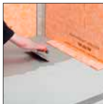
ad 7. Nanieść zaprawę cienkowarstwową
