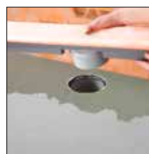
ad 4. Nałożyć rynnę wraz z podstawą
