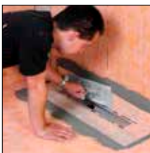
ad 4. Nakleić manszetę KERDI stosując klej KERDI-COLL-L
